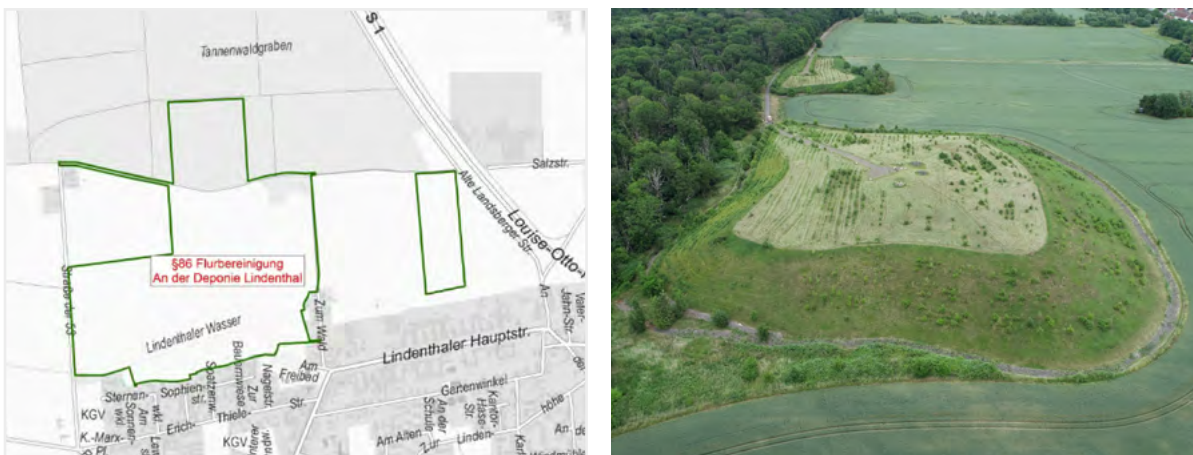
links Lage und Abgrenzung des Verfahrensgebiets; rechts Luftbild im Bereich der Deponie Lindenthal
